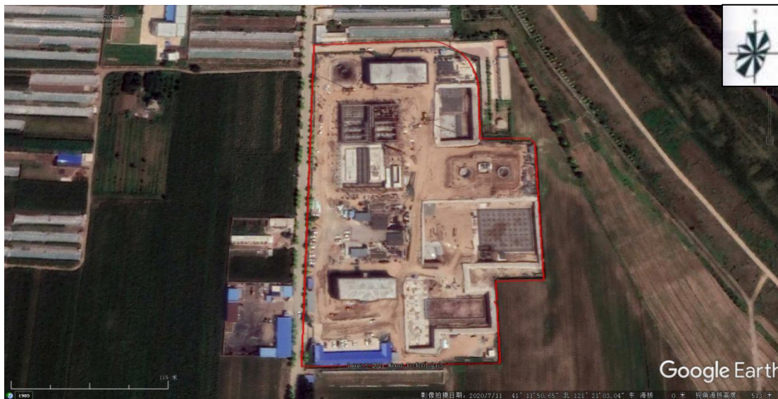
图 3-8 2020 年 7 月历史影像（与 19 年比，地块内净水厂开始建设）
