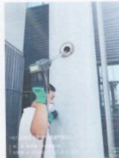
熔化炉排气筒废气进口 经度：121.013173° E 纬度：41.065651° N
