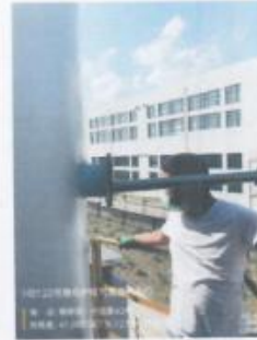
熔化炉排气筒废气出口 经度：121.013183° E 纬度：41.065567° N
