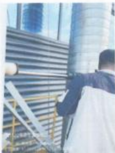
造型废气排放口 经度：121.013301° E 纬度：41.065528° N
